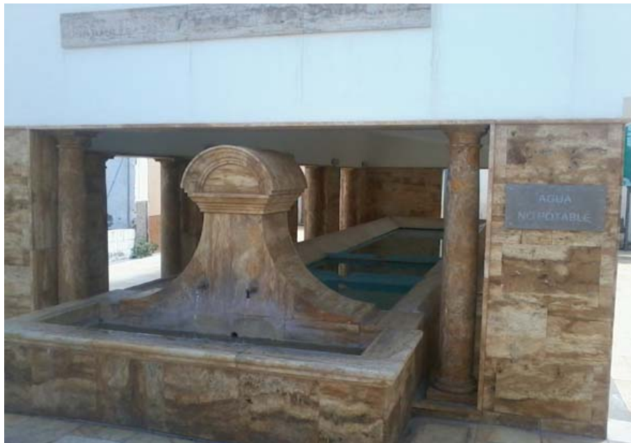
Lavadero de Benahadux (E. Milla, septiembre 2013)
