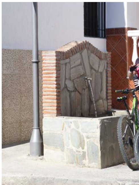
Pilar de Murchas (L. Cano Cavanillas, octubre 2013)
