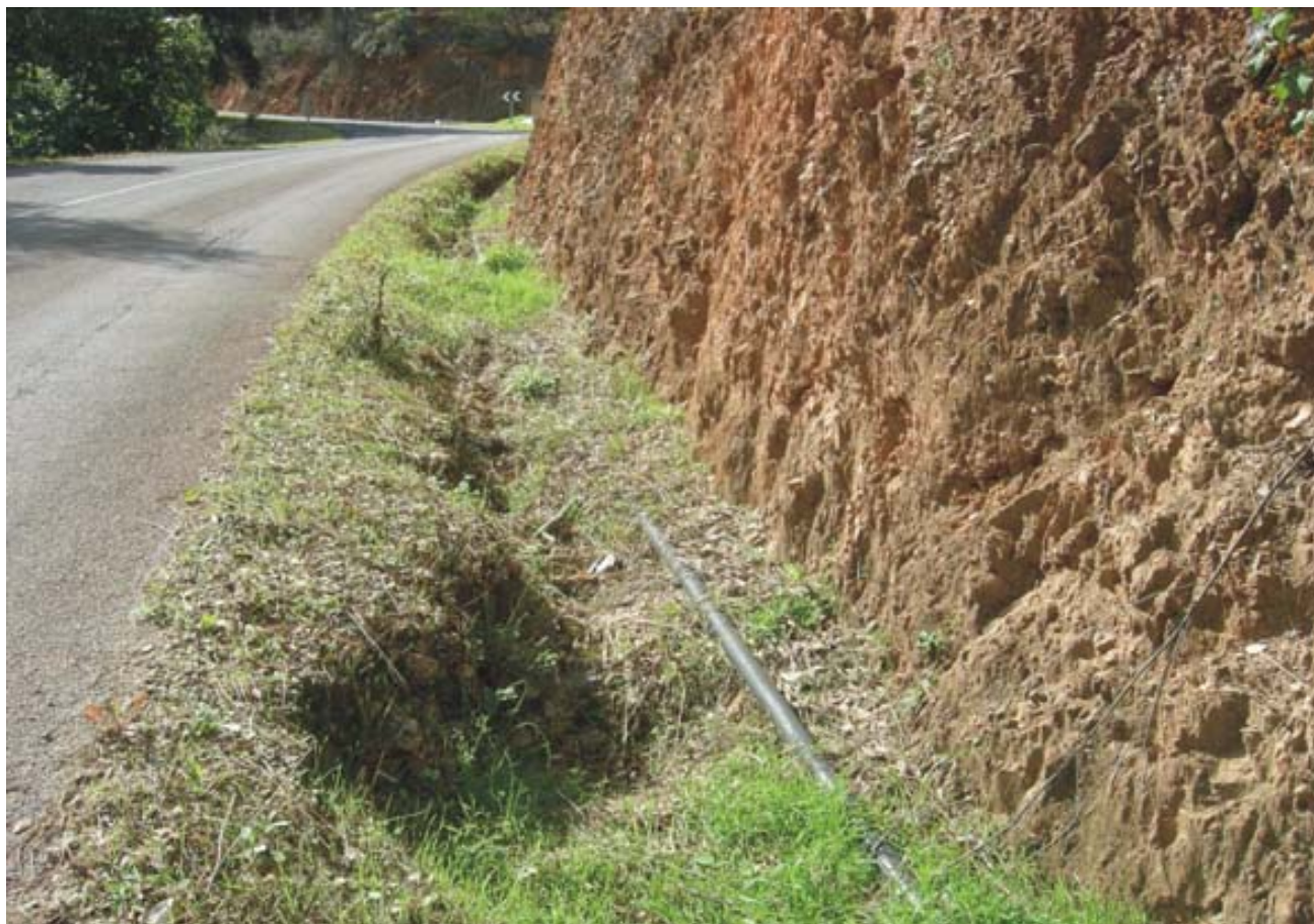
Manguera de goma, que trae el agua del manantial a las primeras huertas del pueblo y a un pilar de la entrada (P. Domínguez García, octubre 2013)
