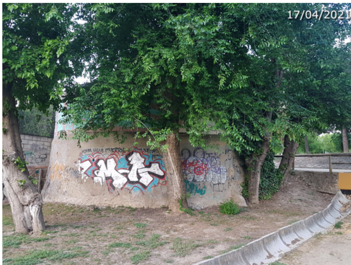
Paredes externas y elevadas del pozo que originaría, por filtración, las aguas del manantial (A. Ventas, abril 2021)
