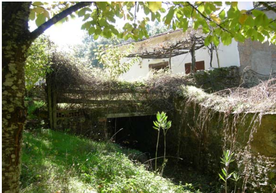
Entrada al depósito del manantial, debajo del acceso a la casa (P. Domínguez García, noviembre 2013)
