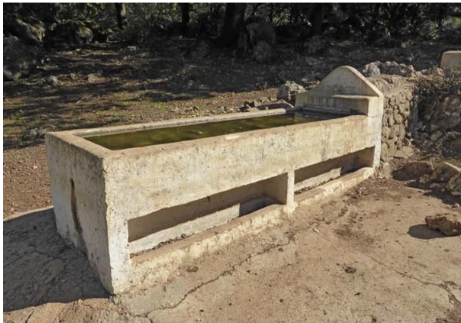
Pilar del ICONA, el abrevadero está adaptado a animales de diverso porte (P. Sánchez Gil, noviembre 2013)
