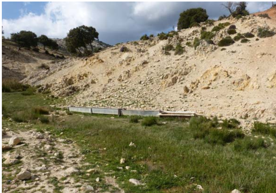
Tornajos del Barranco del Torcal (J. D. Cano Cavanillas, abril 2014)
