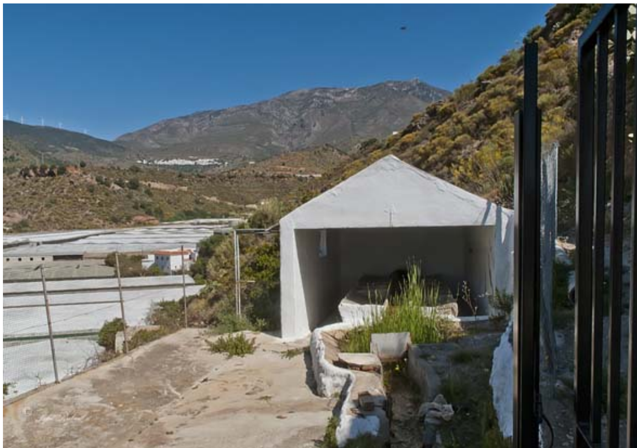
Lavadero de Los Carlos, vista general (J. Rubia González, mayo 2014)
