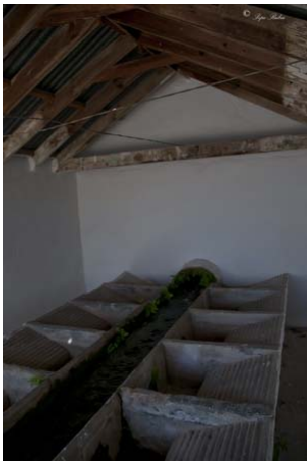
Lavadero de Los Carlos, interior (J. Rubia González, mayo 2014)
