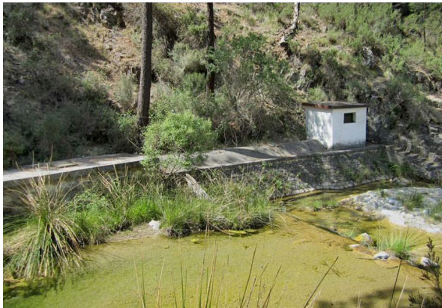
Entorno del manantial, con la caseta de captación al fondo junto al Bacal (A. Aguirre)
