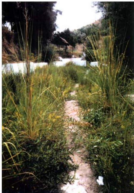
Zanja de drenaje La Rambla (IGME Granada, 1996)
