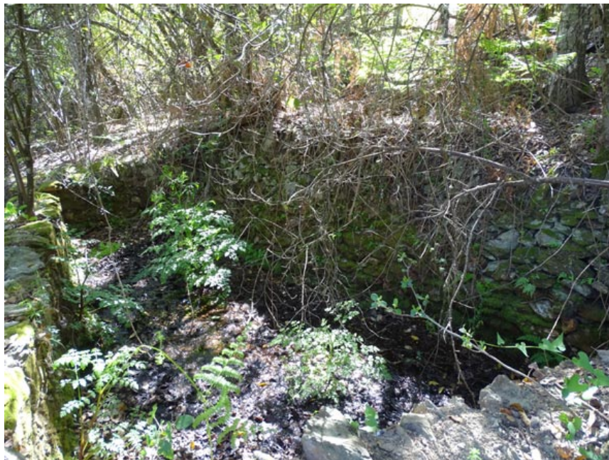
Vista del manantial principal, por su mayor caudal (J. F. Martín Álvarez, abril 2023)
