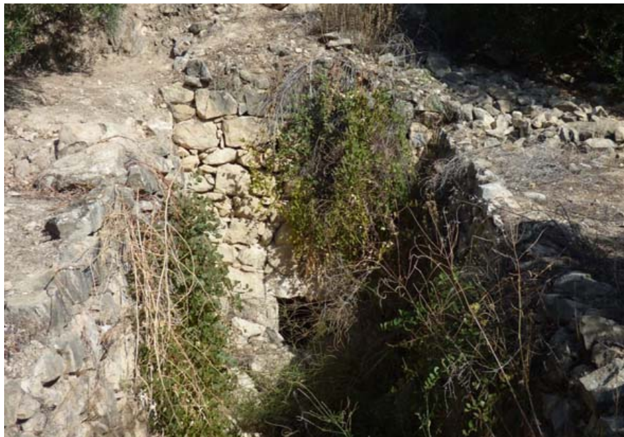
Fuente de Blas (L. Cano Cavanillas, noviembre 2014)
