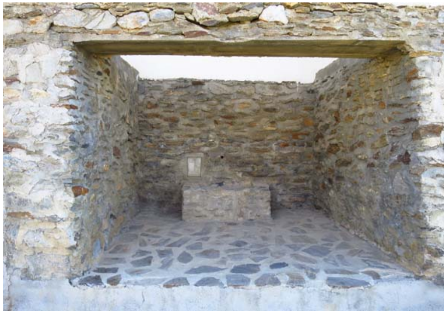
Pilar de mampostería de cemento y esquisto (J. M. Fernández Portal, agosto 2014)
