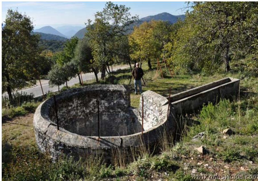
Pozo y abrevadero del Cordel de Arcos (M. Limón Andamoyo, diciembre 2014)
