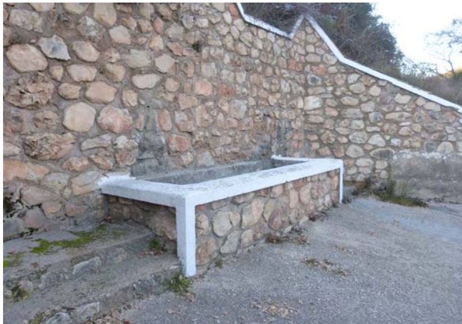
Fuente en el Km. 19 carretera A-314 (J. D. Cano Cavanillas, enero 2015)
