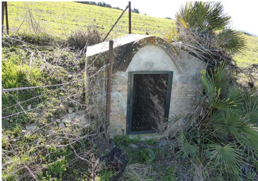
Alcubilla de protección de la entrada a la galería de captación (P. Sánchez Gil, enero 2015)
