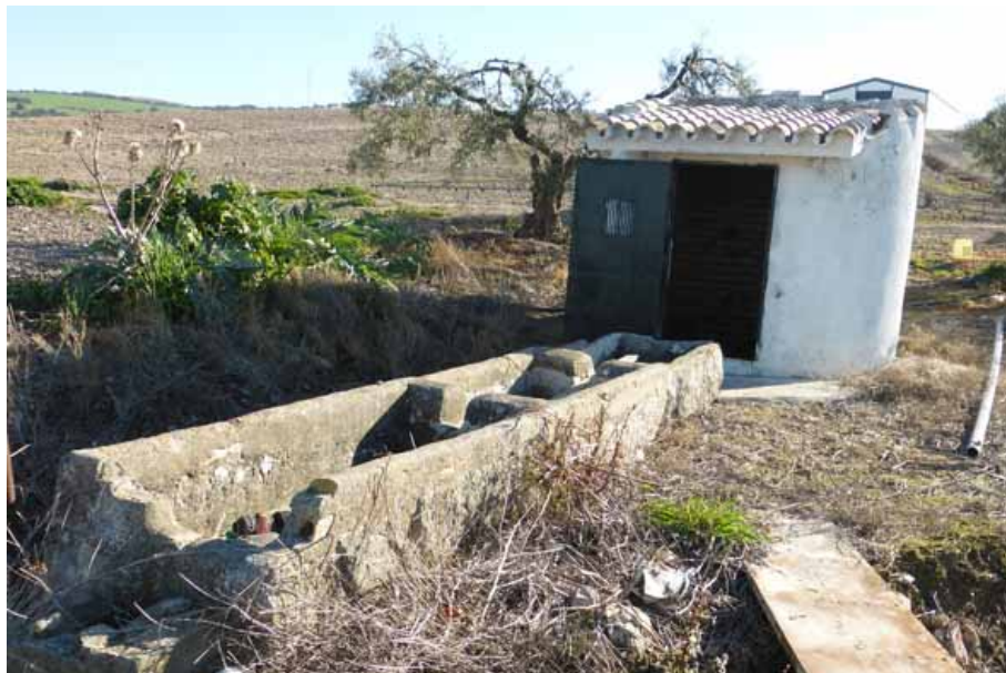
Manantial y abrevadero (P. Sánchez Gil, enero 2015)
