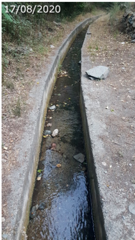
Aguas conducidas de la fuente mediante acequia, tras pasar por el paso del río (A. Ventas, agosto 2020)
