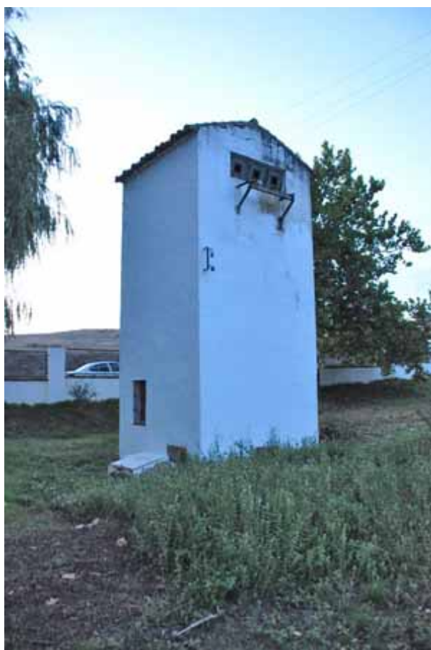
Antiguo depósito de Aguas del Pilar Viejo (M. Limón Andamoyo, octubre 2015)
