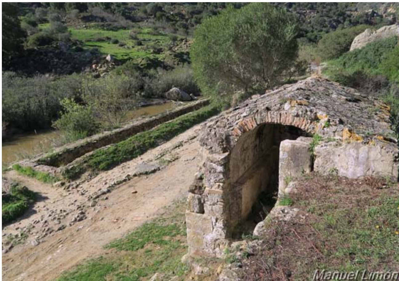
Possible depósito al otro lado del río (M. Limón Andamoyo, enero 2016)
