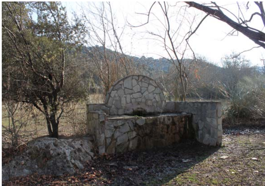
Pilarillo del Puente (T. Peinado Parra, enero 2016)
