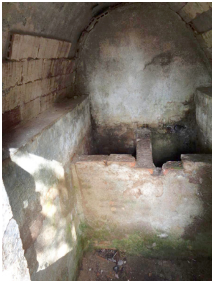
Interior de la caseta de captación (A. Conejero, marzo 2021)
