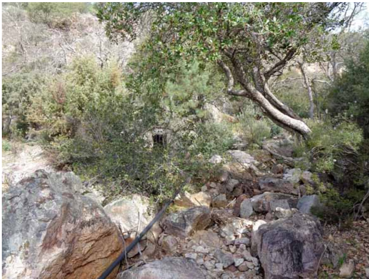
Conducción de agua desde la caseta de captación, al fondo (A. Conejero, marzo 2021)
