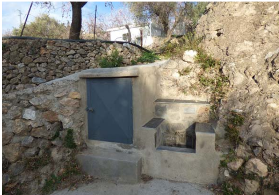
Fuente del camino de Notáez (L. Cano Cavanillas, febrero 2016)
