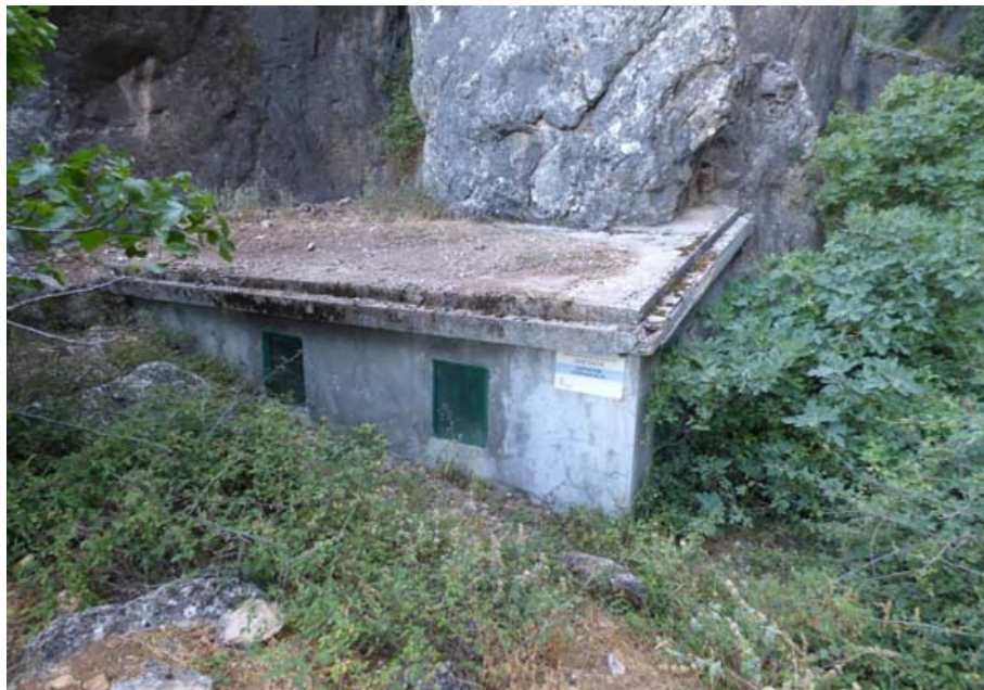
Captación de la Cerrada Alta (J. D. Cano Cavanillas, septiembre 2016)
