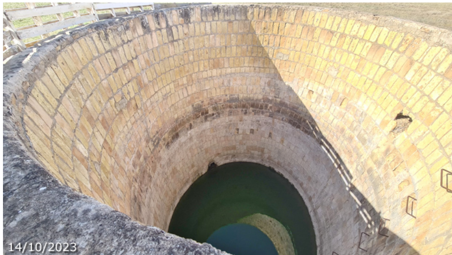
Alberca, perimetrada, con la fuente abajo (A. Ventas, octubre 2023)
