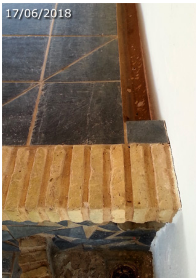
Desagüe del agua de las pilas (A. Ventas, junio 2018)
