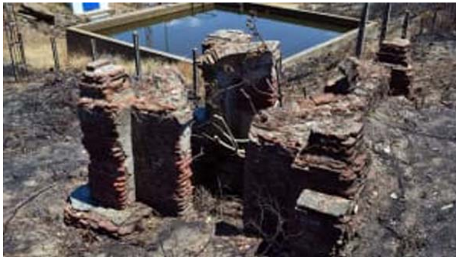
Fuente del Escribano, al fondo la depuradora ( www.valverdeverde.com )
