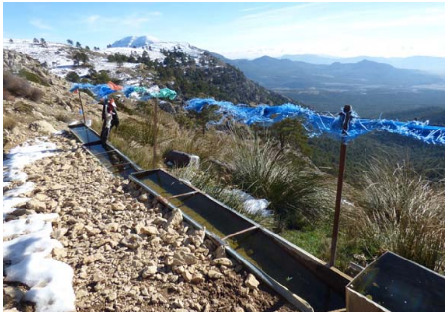
Tornajos de la Tinada del Chaparral (L. Cano Cavanillas, diciembre 2016)
