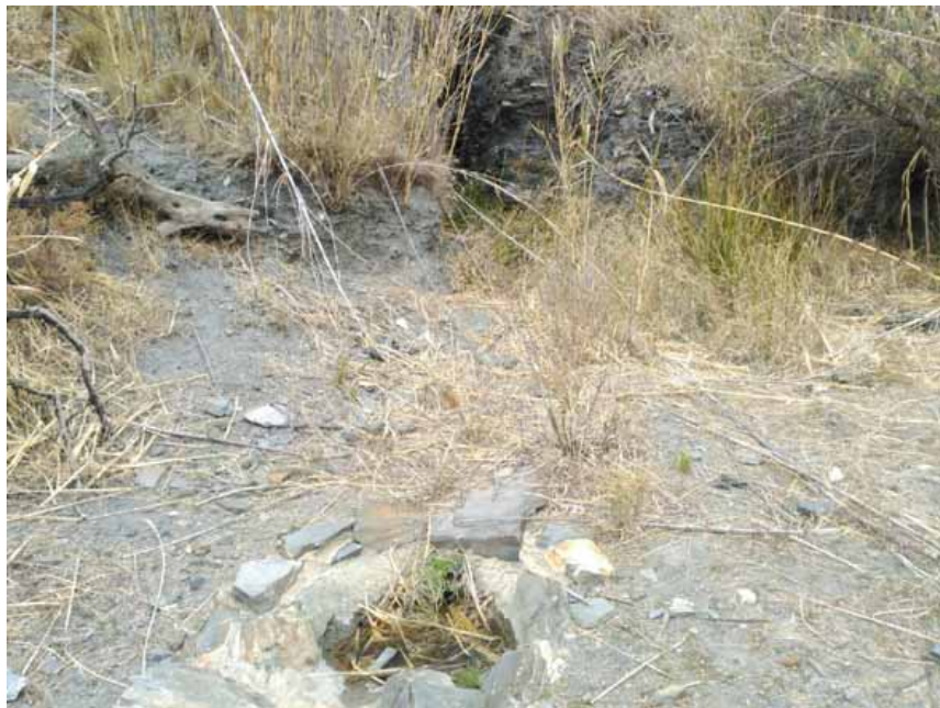
Entrada a la fuente. En la parte inferior se observa un pequeño estanque donde se acumula el agua (A. García Martínez, enero 2018)
