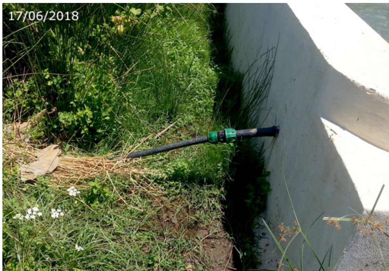
Entubamiento para riego de la salida inferior del agua (A. Ventas. junio 2018)
