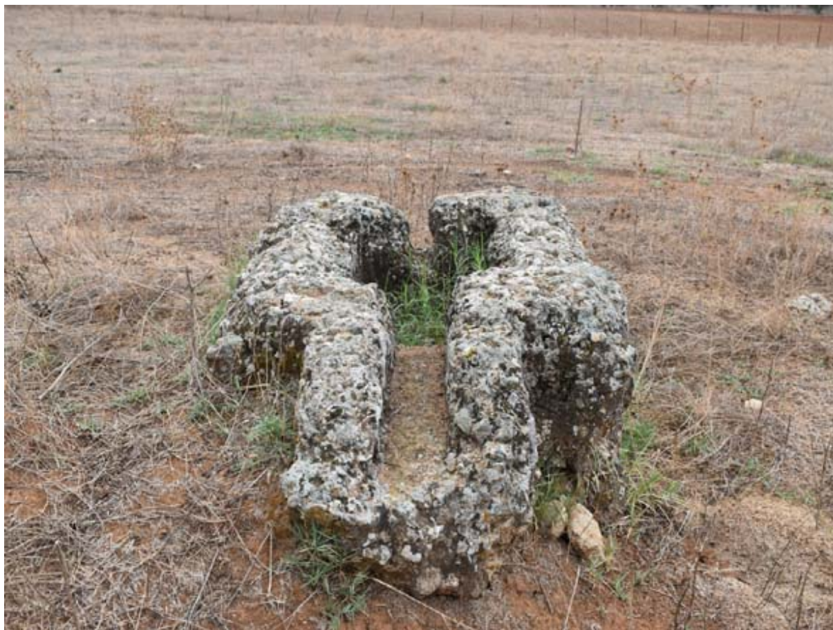
Tramo de acueducto de la villa romana de Angorrilla, en la dehesa Cortijo Caballo (A. Márquez Pascual, octubre 2018)
