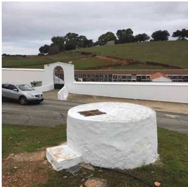
Pozo del Cementerio (J. M. Fernández-Palacios, noviembre 2018)
