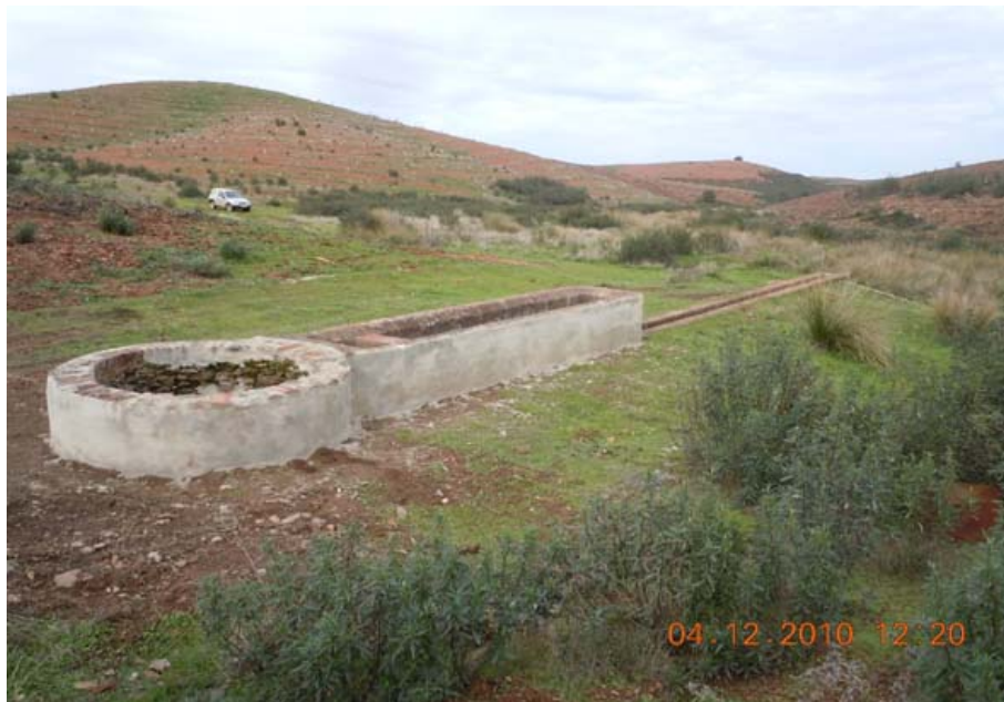
Pozo del Pilar (M. Mora Tenorio, diciembre 2010)
