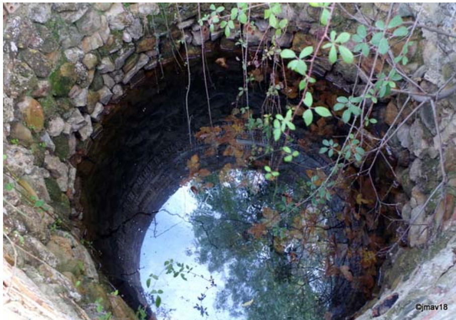
Pozo donde se recoge el agua. Abajo a la derecha el tubo de rebose (J. M. Amarillo Vargas, diciembre 2018)
