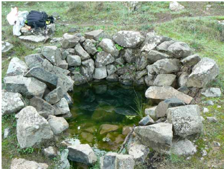
Fuente de la Rajela, Brocal de rocas muy rústico pero efectivo para retener el agua (J. Sanchoi Pérez, 2005)
