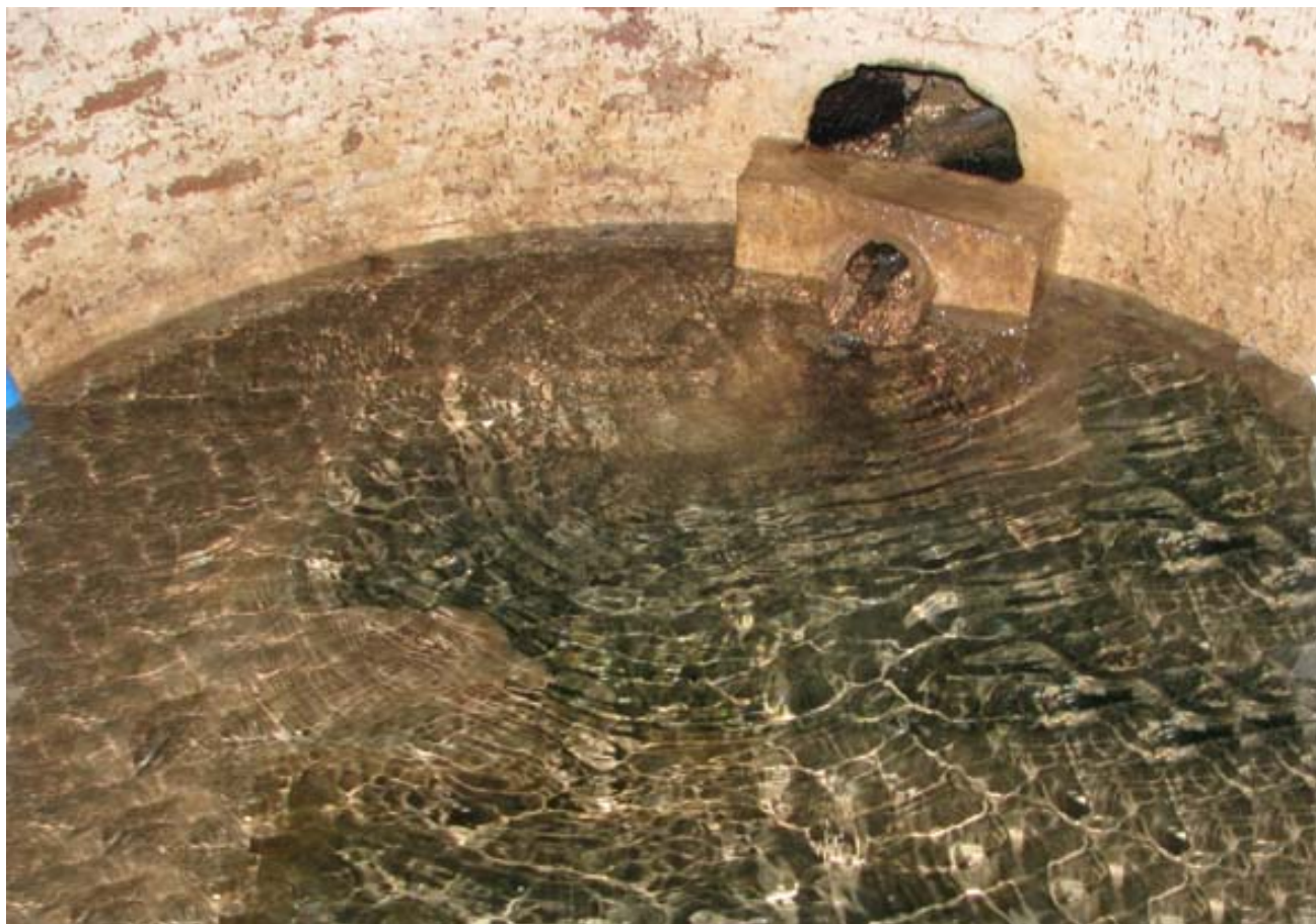
Interior y entrada de agua a la alcubilla (F. Muñoz Carreras, noviembre 2016)
