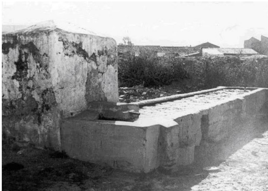
Aspecto del pilar antes de ser demolido, reducido a la mitad de sus dimensiones originales (Década de los 60-70. Archivo Antonio Rico)
