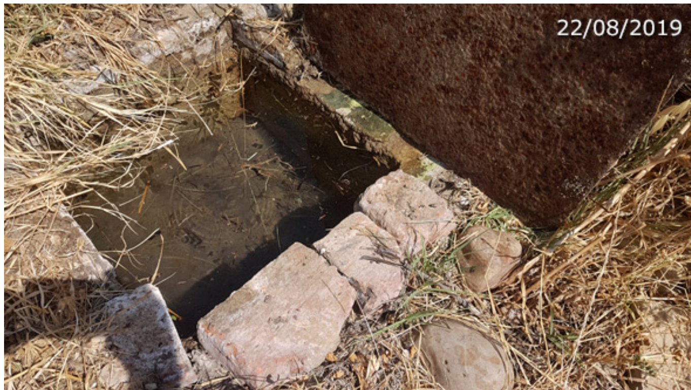
Alcubilla abierta, observando dimensiones, agua y plancha metálica (A. Ventas, agosto 2019)
