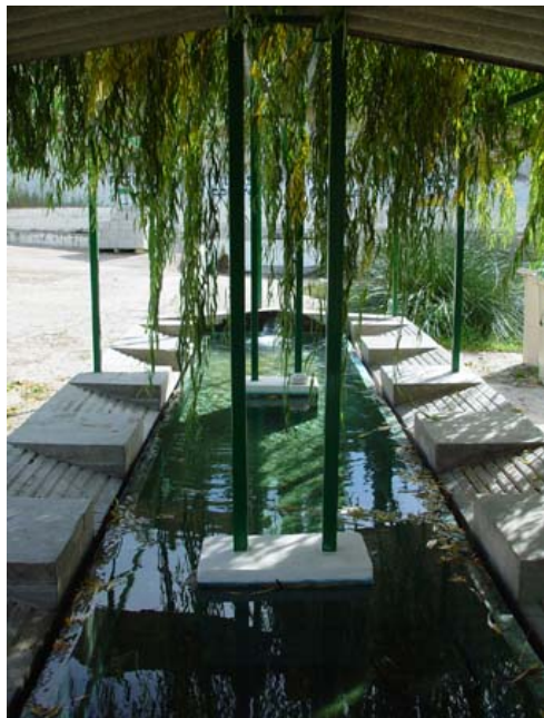
Lavadero de Los Tubos (C. Herrera, noviembre 2005)
