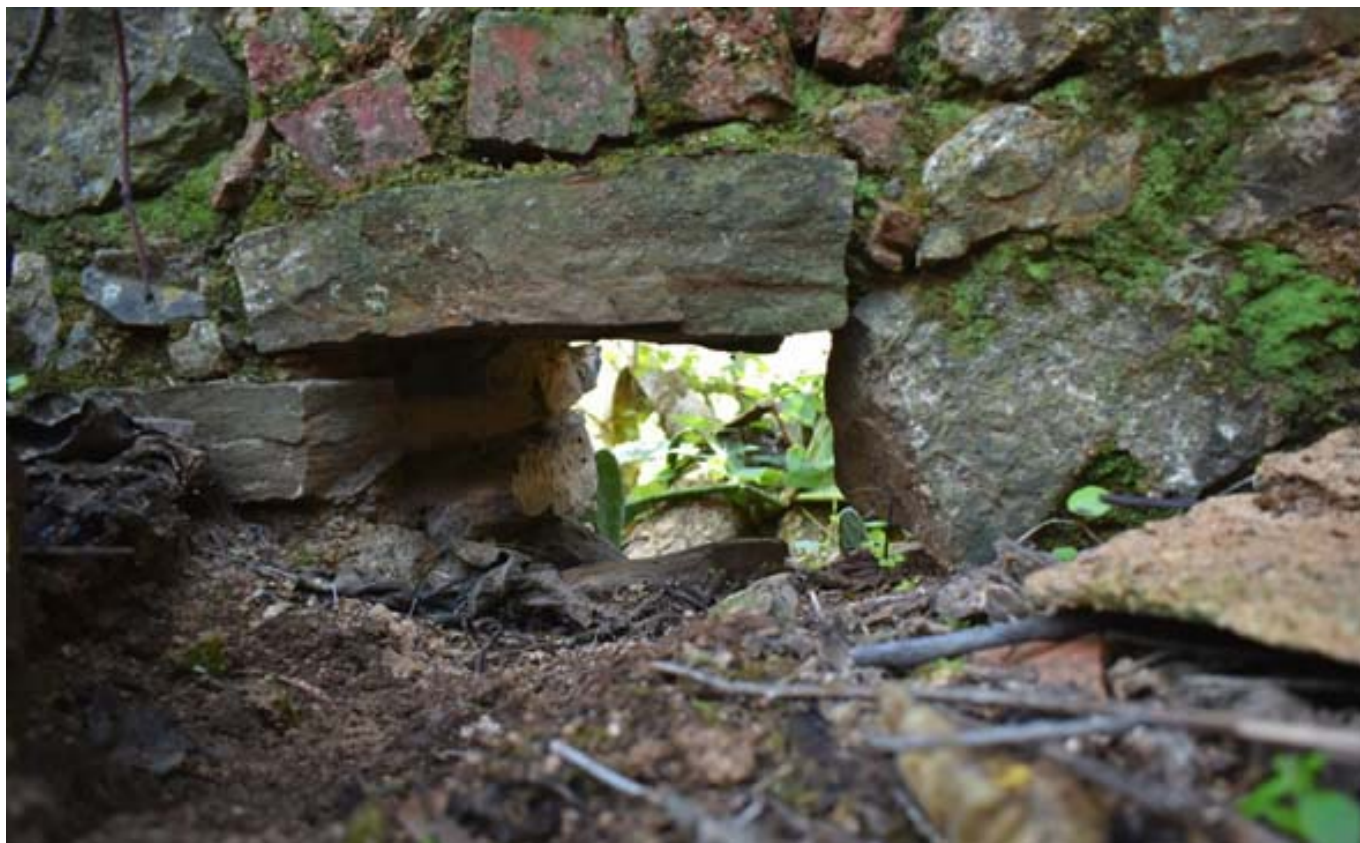
Desagüe del patio interior (Antígona M. Pascual, enero 2020)
