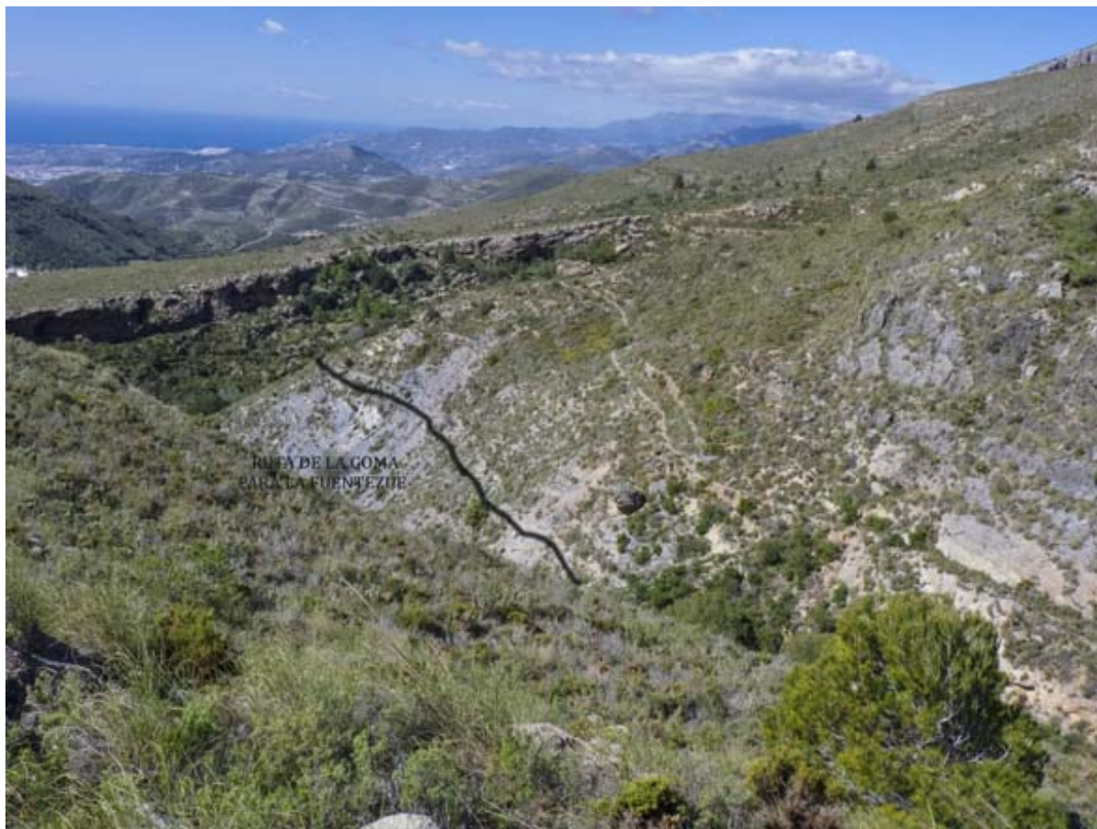
Tubería procedente dell manantial (J. Rubia González, marzo 2020)
