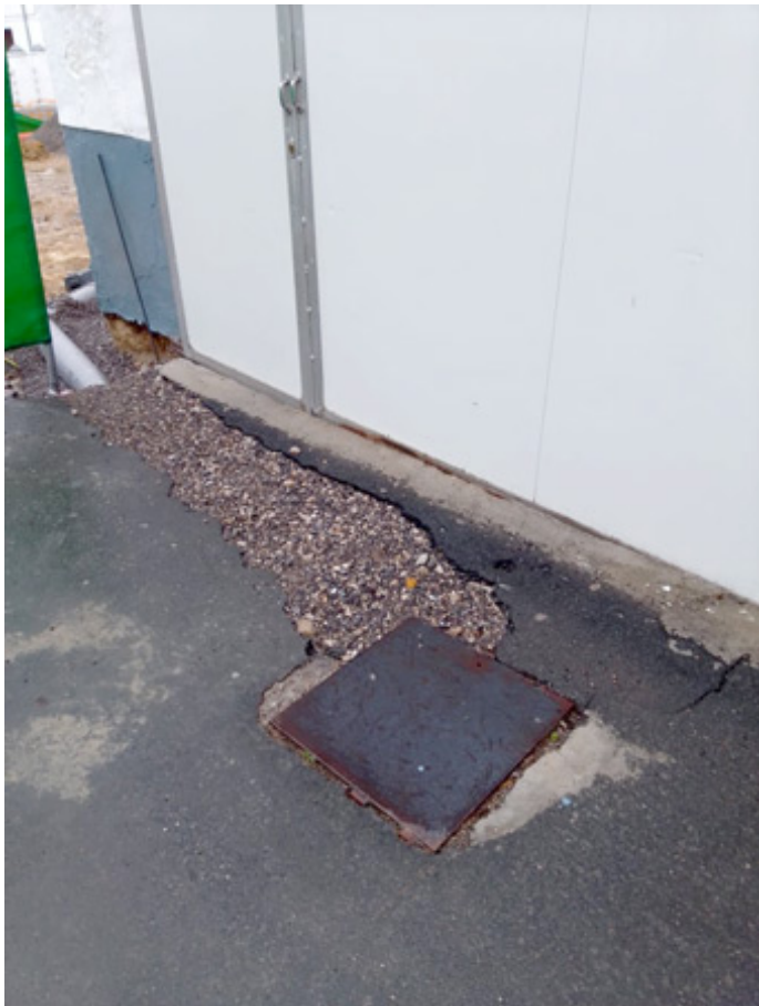
Arqueta cercana a la plaza para la división de las aguas del nacimiento que alimentan pilar y lavadero (C. Cano, abril 2020)
