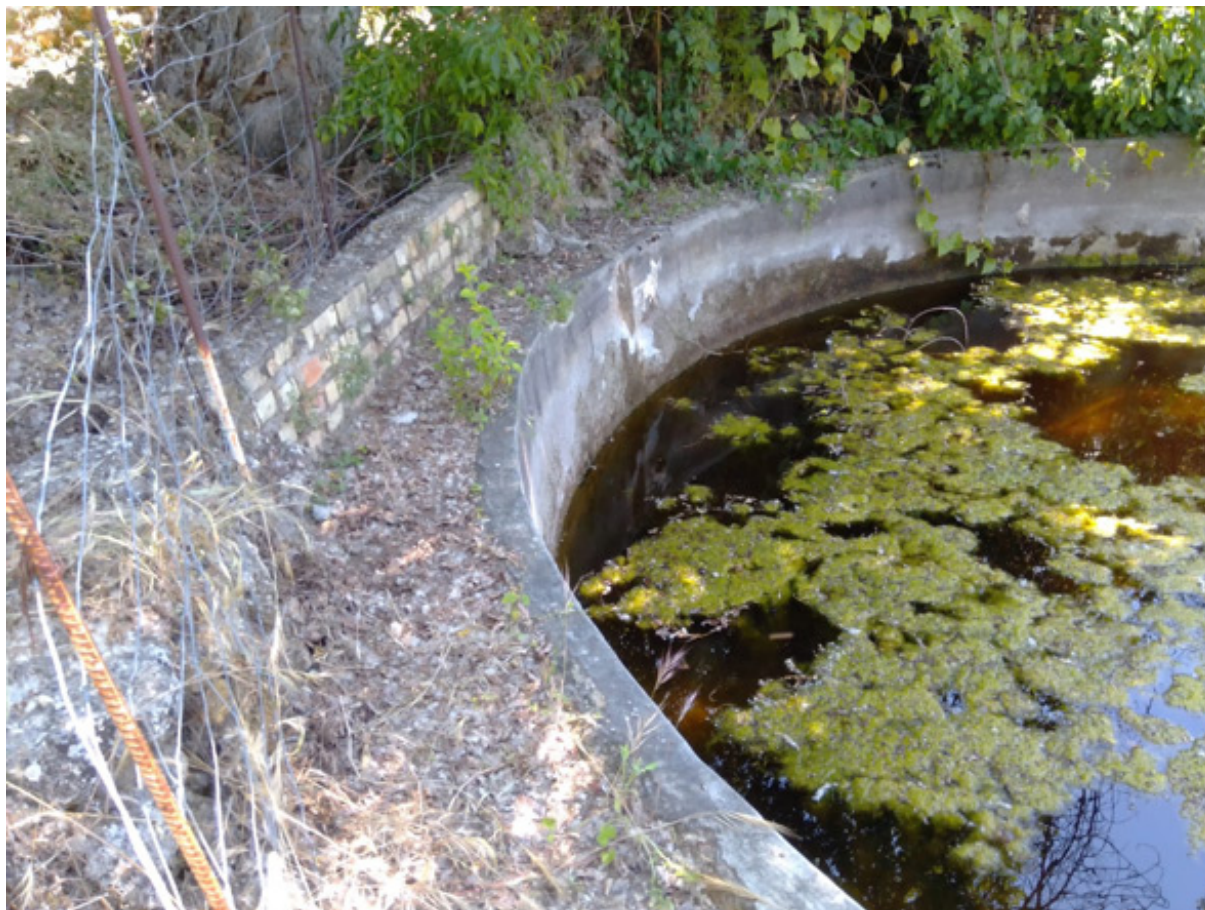
Muros y vallado de protección de la alberca (C. Cano, mayo 2020)
