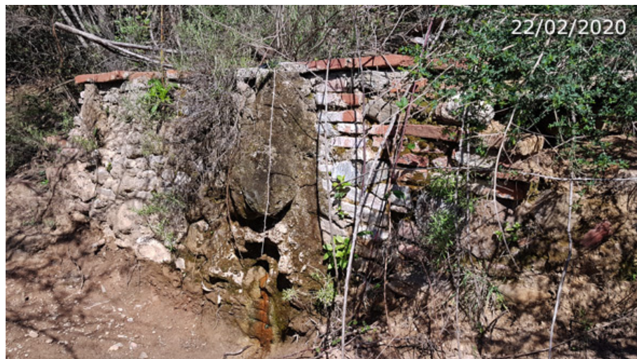
Fuente del tejár, murete de la pileta (A. Ventas, febrero 2020)
