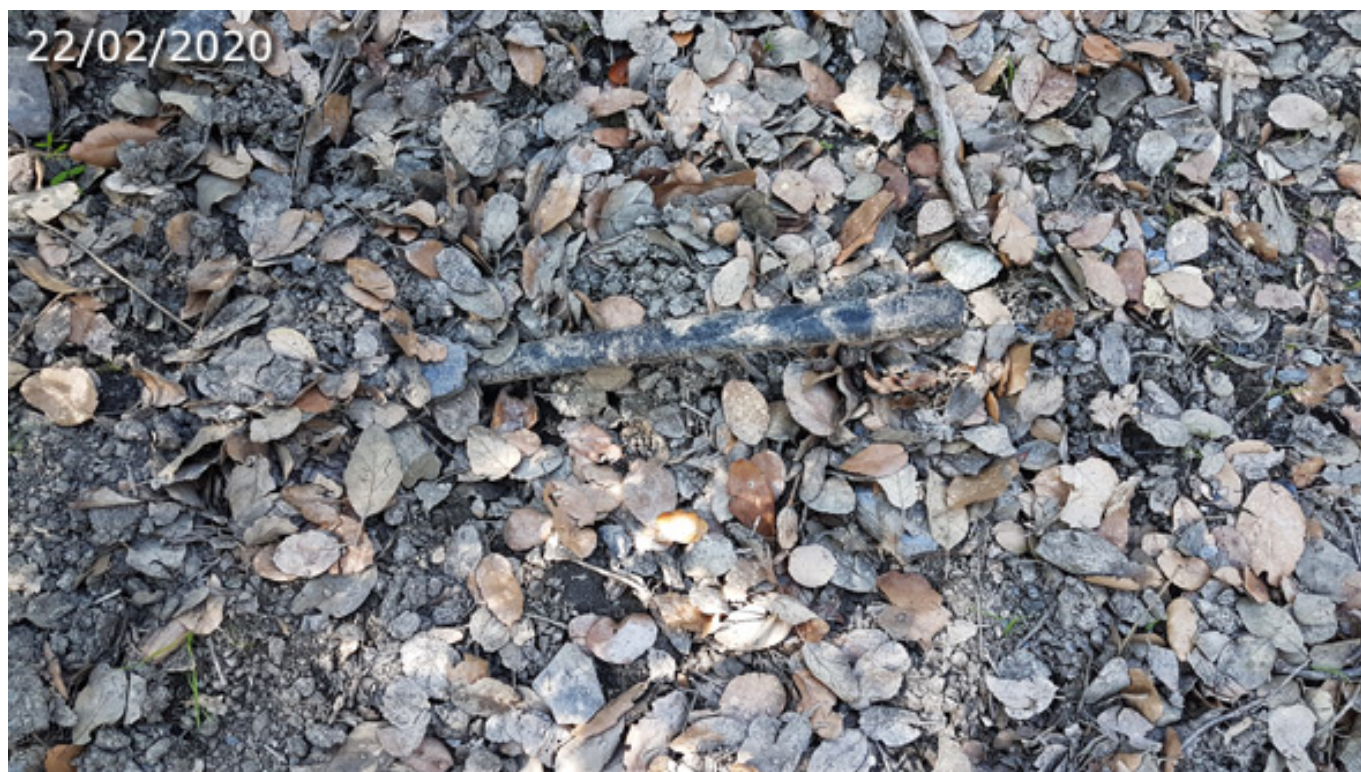
Tubo de riego tras el carril, con dirección a los restos de la fuente (A. Ventas, febrero 2020)
