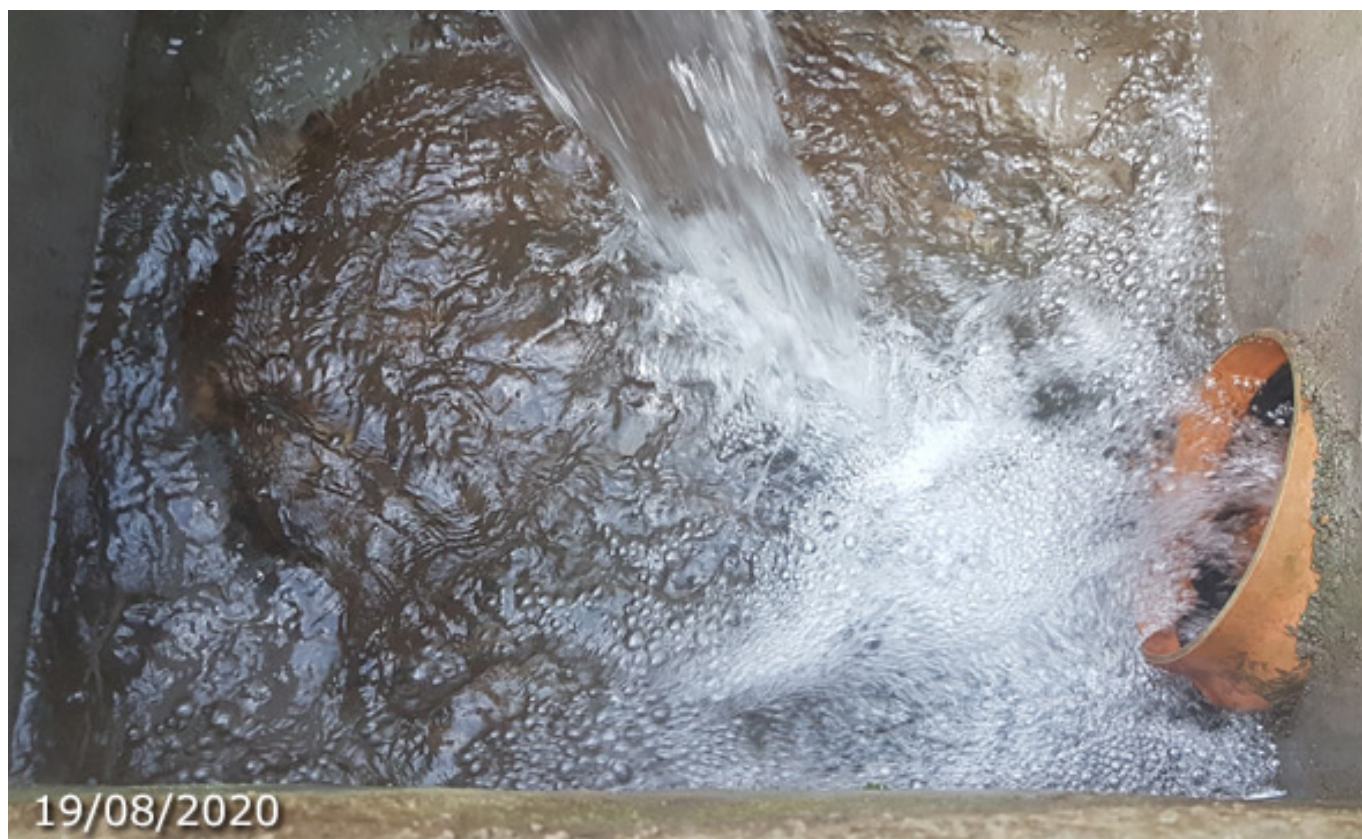
Interior de la arqueta que captación de la fuente, con salida de a la conducción inferior (A. Ventas, agosto 2020)
