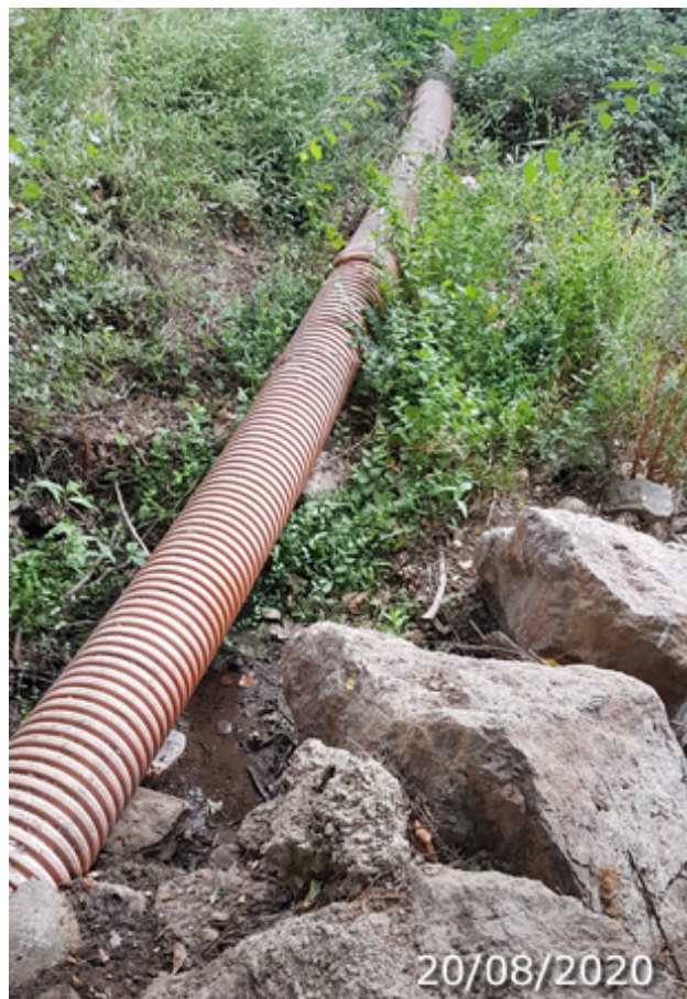
Canalización del agua hasta la acequia, mediante tubo corrugado (A. Ventas, agosto 2020)
