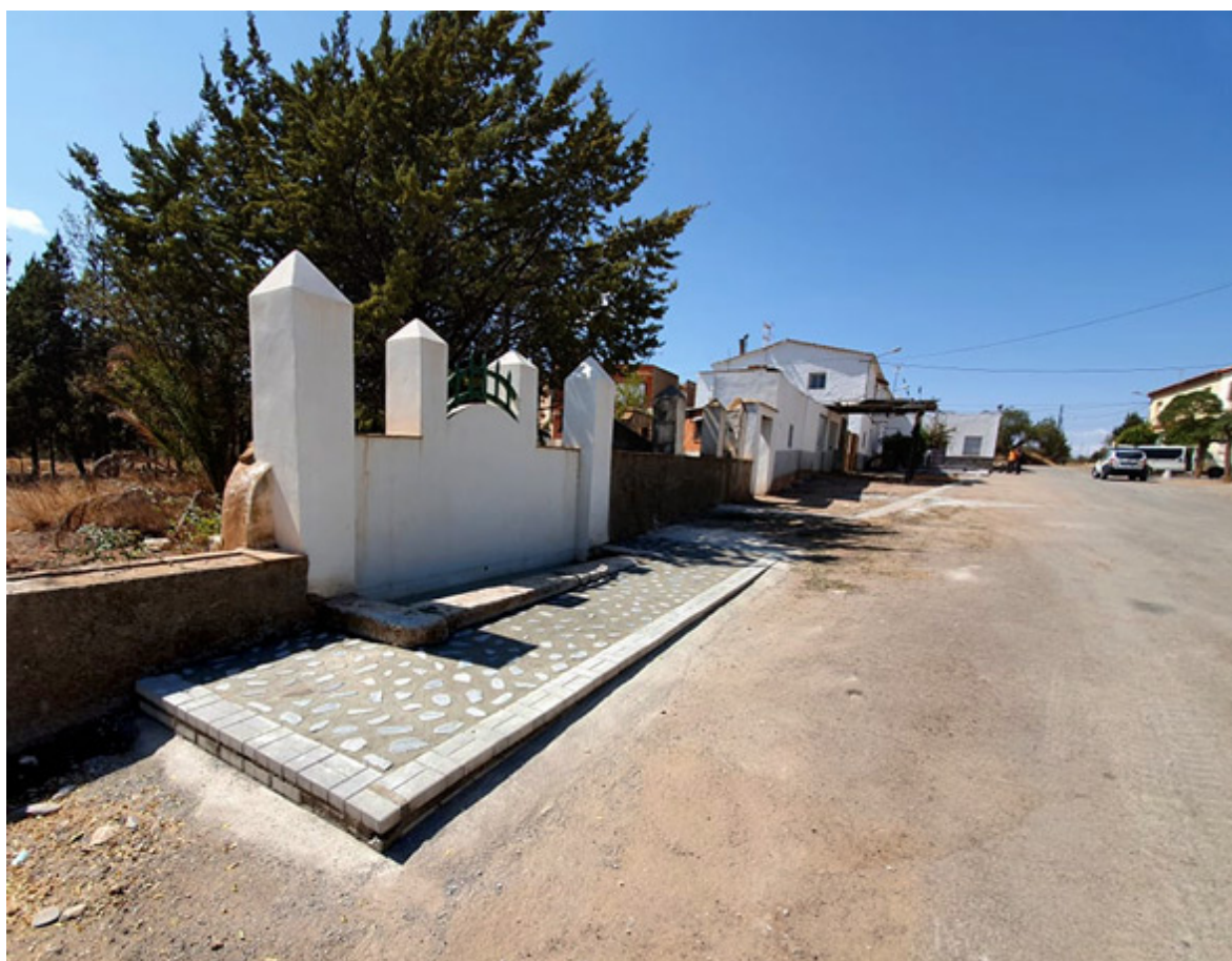
Aspecto general del abrevadero y del suelo colindante, tras la restauración de 2020 (Ayto. Fiñana. Septiembre de 2020)
