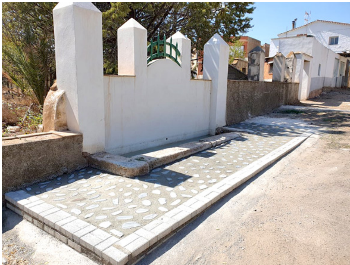
Aspecto del abrevadero tras la restauración de 2020 (Ayto. Fiñana. Septiembre de 2020)
