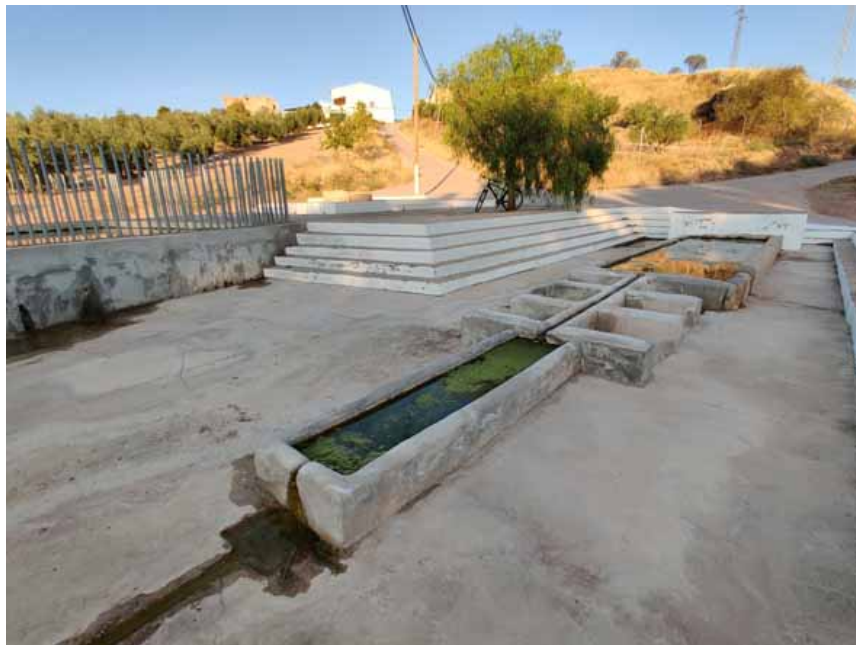
Pilar de Torrequebradilla (D. Sánchez Garrido, octubre 2020)
