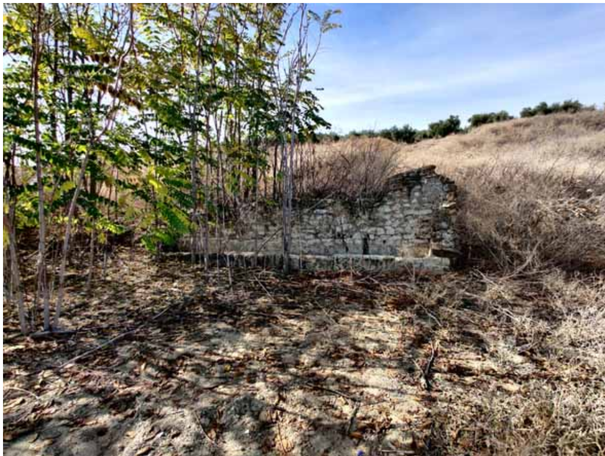
Pilar abrevadero de Macarena, semiabandonado entre ailantos y maleza (D. Sánchez Garrido, noviembre 2020)
